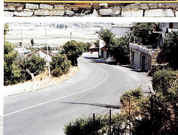
Ασφαλτόστρωση εισόδου Δήμου Αργυροκάστρου, ΚΑΒ 2000
