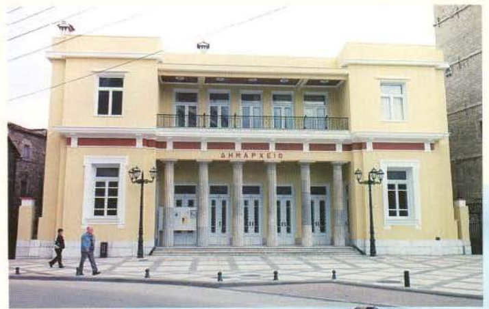
Δεξιά: Δημαρχείο Κοζάνης. Ανάπλαση νεοκλασικού κτιρίου (1930) στο ιστορικό κέντρο της πόλης. Κάτω Δεξιά: Αναστήλωση χαρακτηριστικού Κωδωνοστασίου της περιοχής (1855) στο ιστορικό κέντρο
