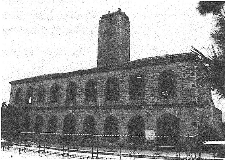
Ερμούπολη: Ερείπιο παλιού Βιομηχανικού κτιρίου, (Σκαγιάδικο 1885). Προορίζεται να στεγάσει το Βιομηχανικό Ιστορικό Μουσείο της πόλης.
